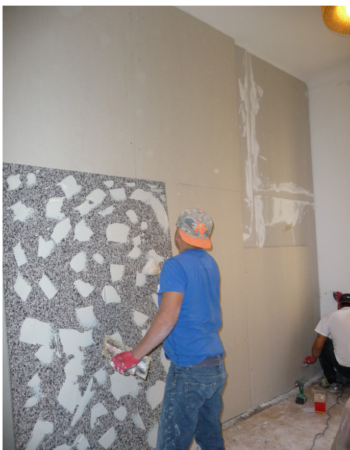
FASE 6 - posizionamento del secondo strato di pannelli HABITAT II
