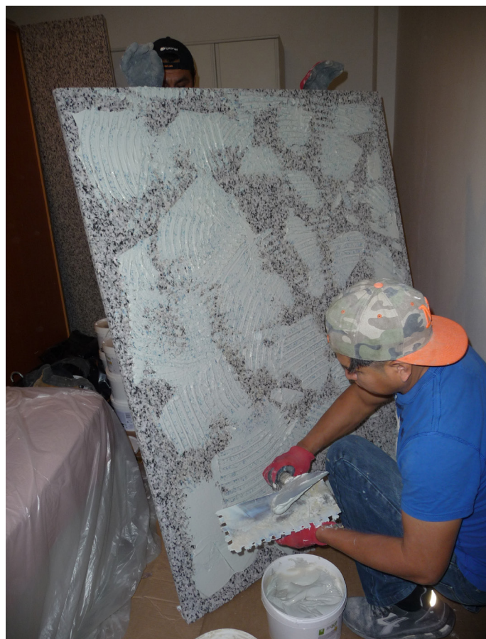
FASE 3 - Incollaggio lastre con colla
