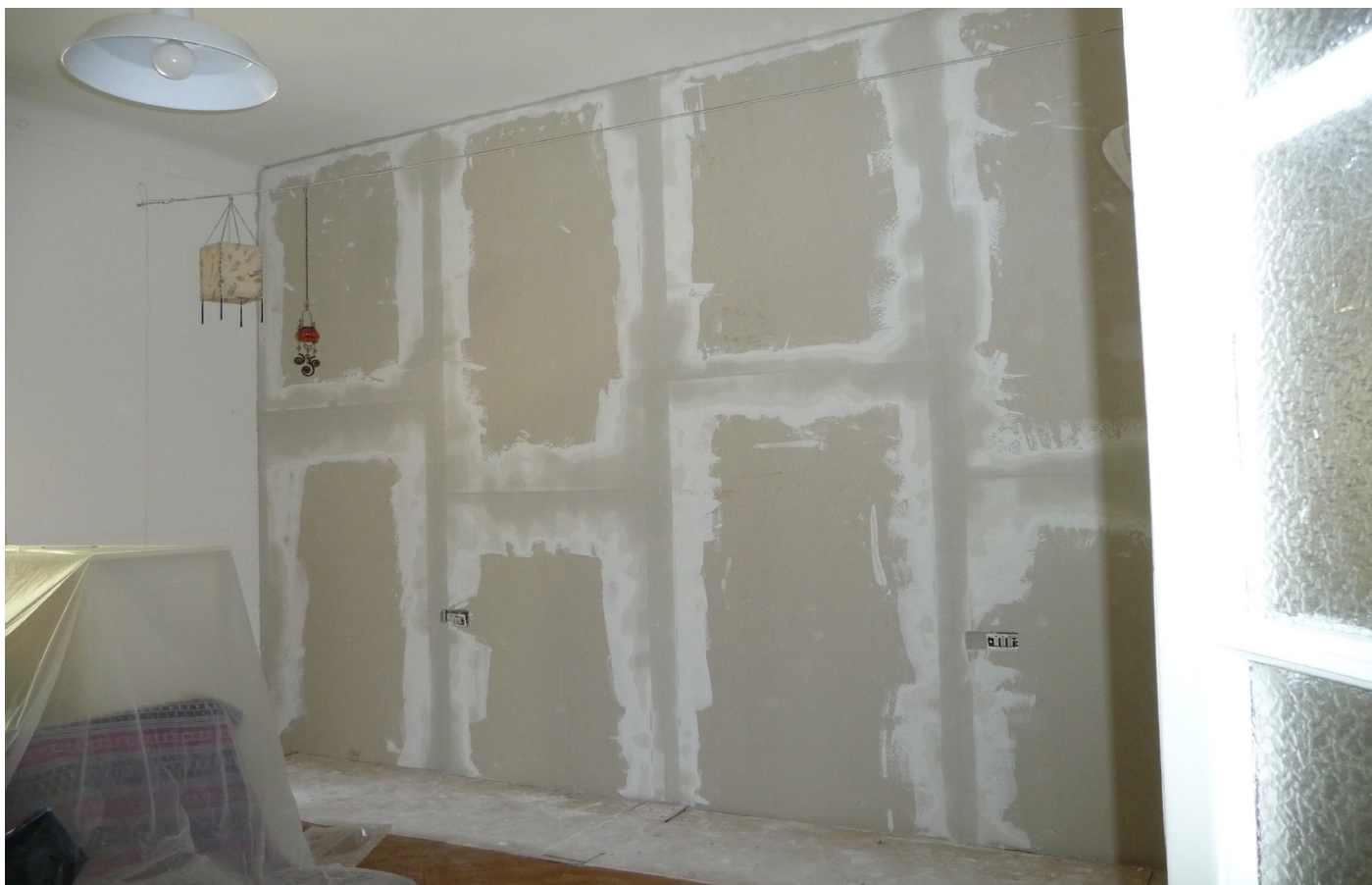
FASE 6 - posizionamento del secondo strato di pannelli HABITAT II - sigillatura, stuccatura e rasatura
