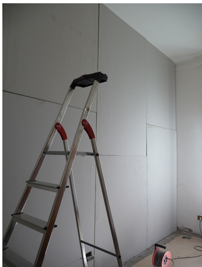
FASE 4 - Accostamento del primo strato di pannelli Habitat I alla parete esistente
