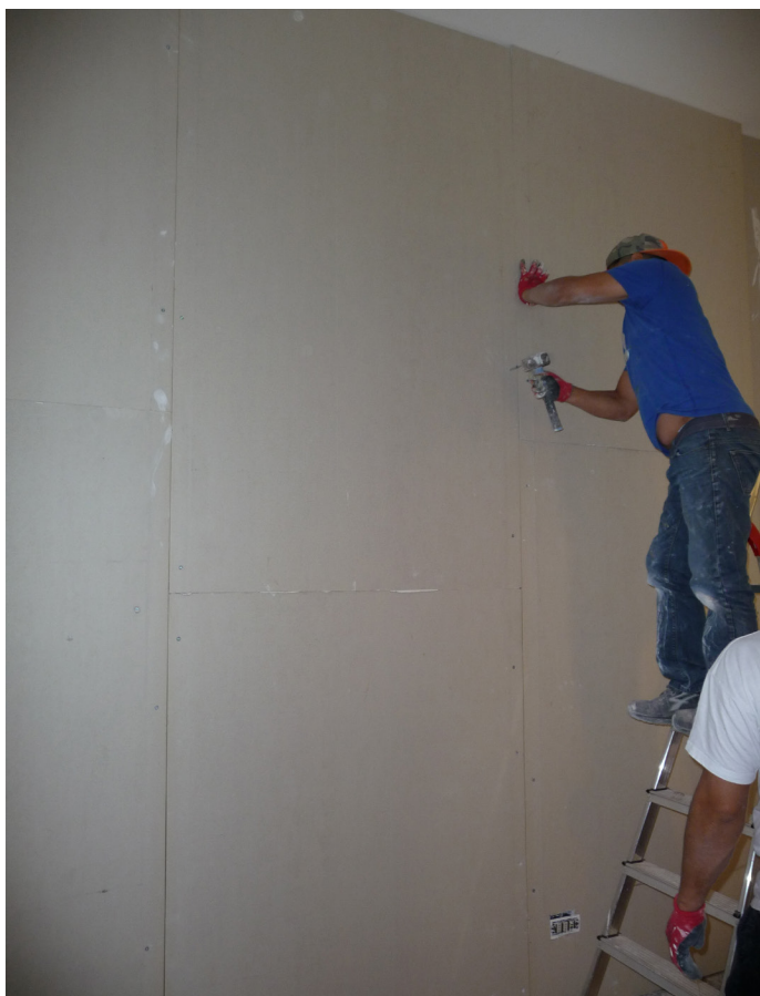
FASE 5 - Sigillatura di tutte le fessurazioni tra i pannelli
