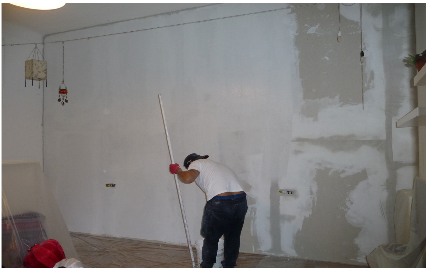
FASE 7 - Finitura delle pareti con almeno tre mani di vernice e ricollocazione prese elettriche e battiscopa.
