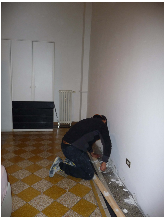
FASE 1 - Preparazione parete - rimozione zoccolino
